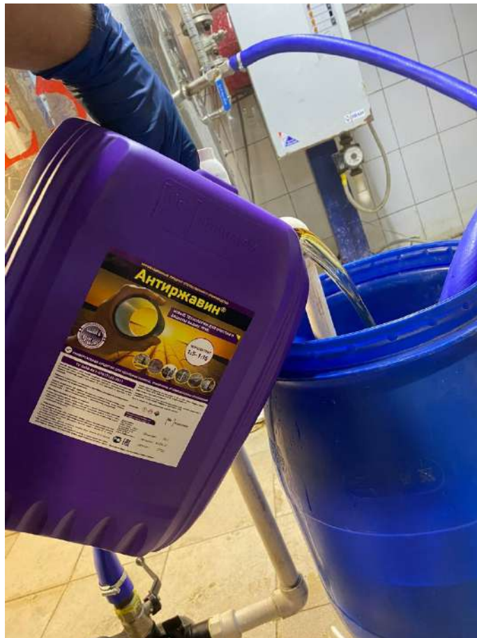
Рисунок 5 – Приготовление рабочего раствора для промывки
